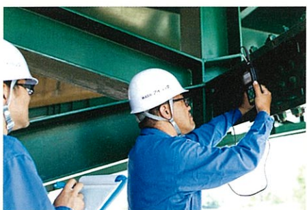
▲建造物の安全を守るべく検査する社員
